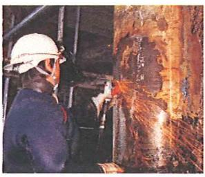
母材に溶接位置のマーキング 溶接部の表面処理
